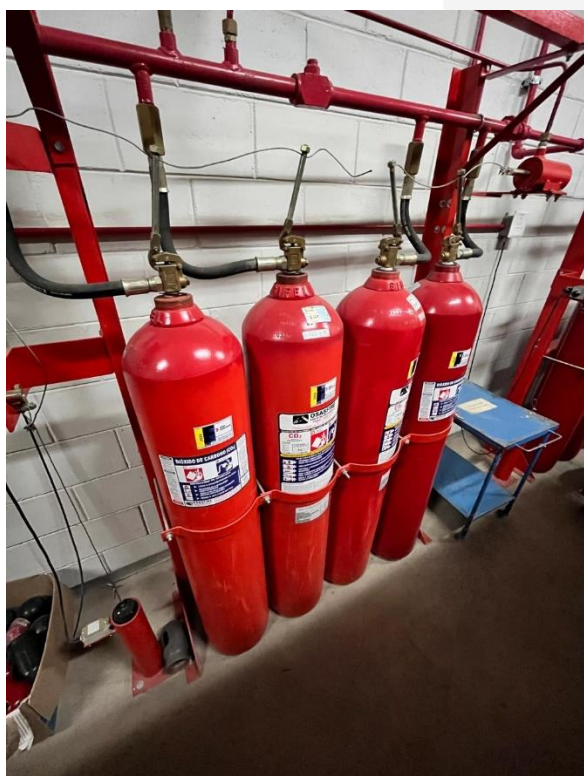
Figura 1. Modelo de baterias de CO2 existente
