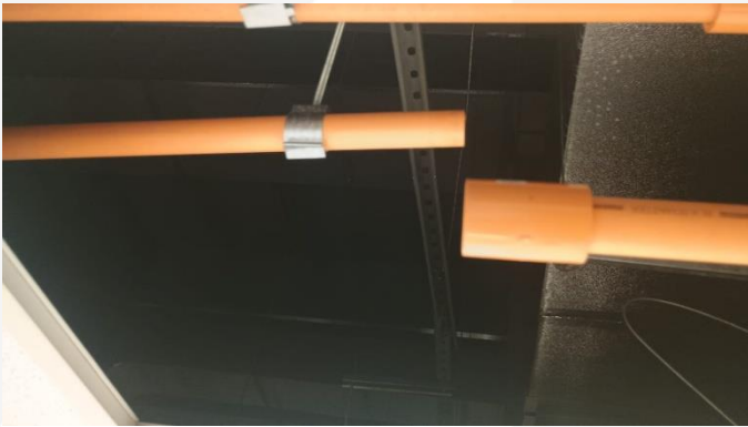
Foto 19: Sera necessario colar toda a tubulacao do vesda.
