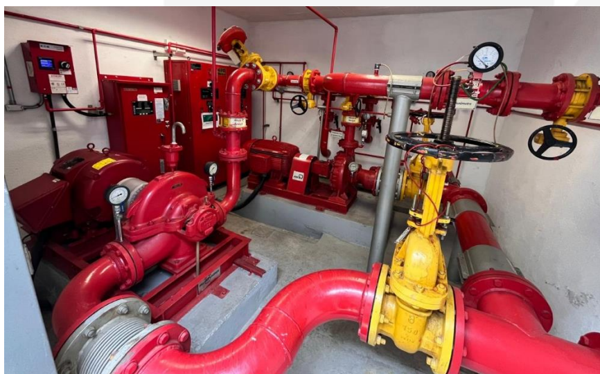
Foto 04: Case de Bomba do local
