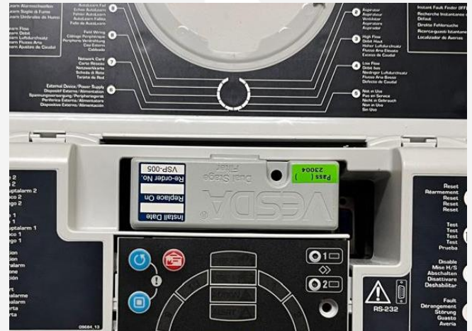
Foto 08: Filtro VESDA VLF-250 sem data de vencimento identificado
