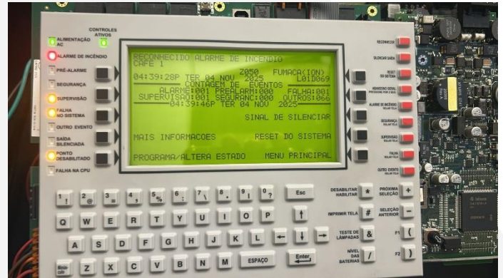
Foto 20: Teste nos detectores de fumaça
