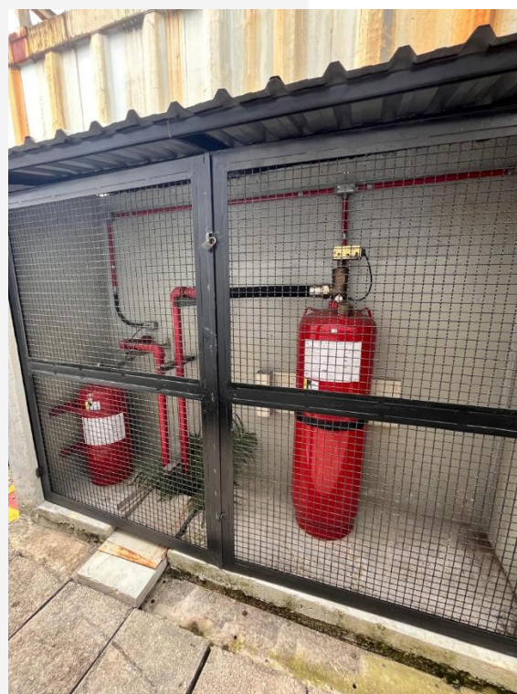
Figura 2. Modelo de FM-200 existente
