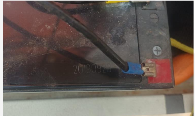
Foto 06: Data de fabricação das baterias das fontes
