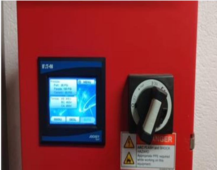
Foto 15: Foi realizada a calibragem do painel da bomba jockey. Funcionar, necessário a troca.
