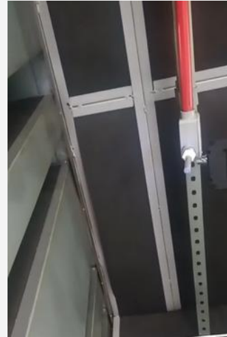
Foto 12: Detector de calor sem atuação
