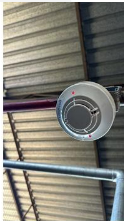
Foto 14: Realizada a troca do sensor do tanque diesel L05D158
