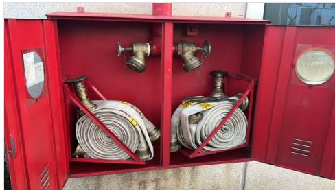
FOI COLOCADO AS MANGUEIRAS NOS ABRIGOS.
