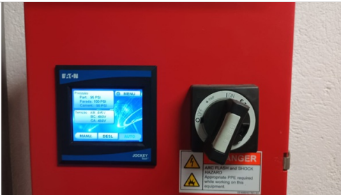
REALIZADA A CALIBRAGEM NO PAINEL DA BOMBA JOCKEI.
