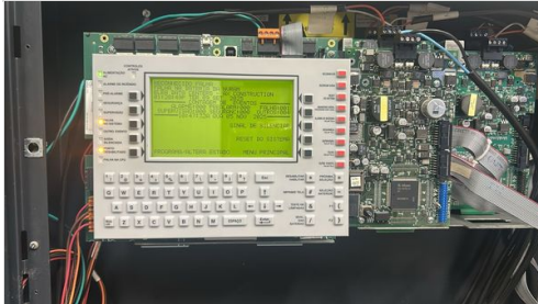
INICIO DA MANUTENÇÃO
